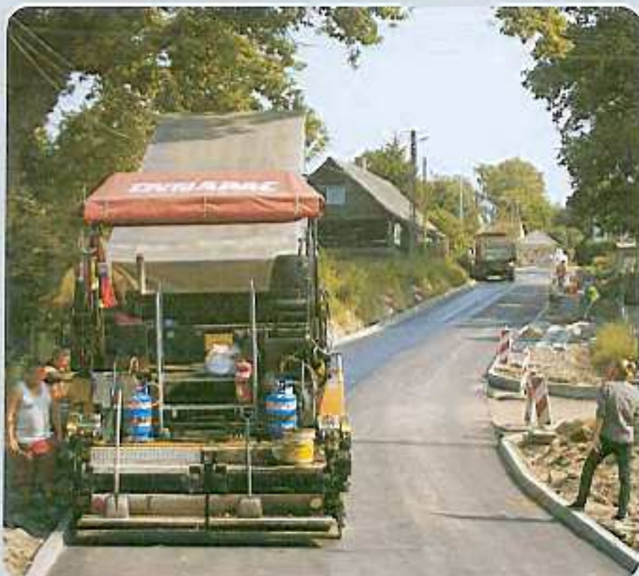
Wykonawca podczas układania warstwy ścierniczej musiał zwracać uwagę na nową infrastrukturę, która została wbudowana w jezdnię.
