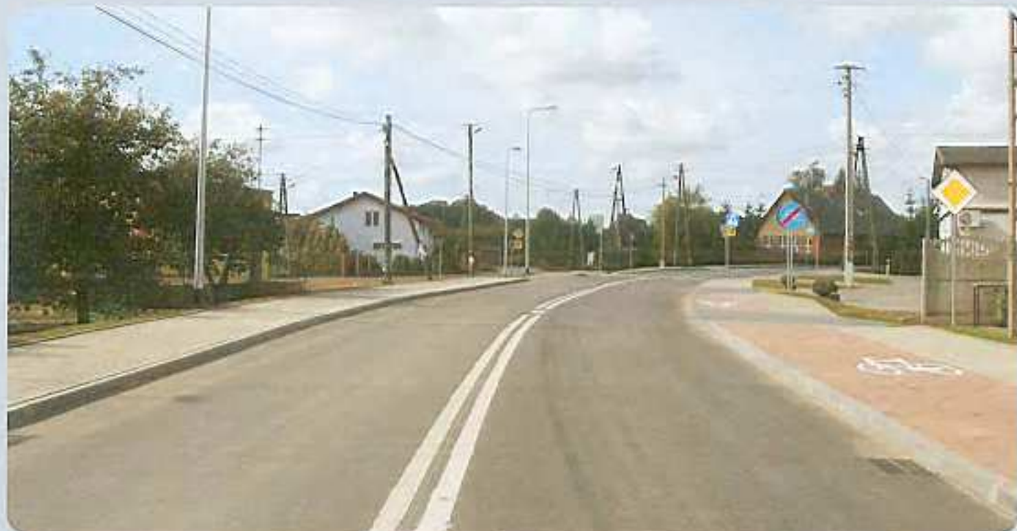
Na zmodernizowanej drodze wykonano nowe oznakowanie poziome i pionowe.
