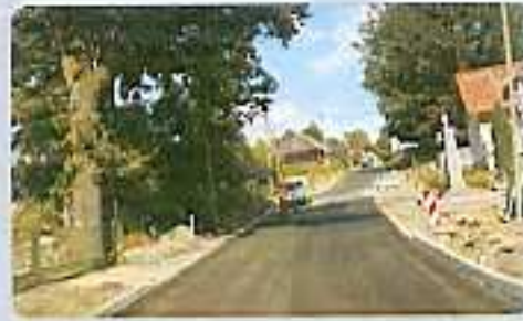
Prace na DW nr 239 wykonywane były pod ruchem w tak zwanym systemie połówkowym.
