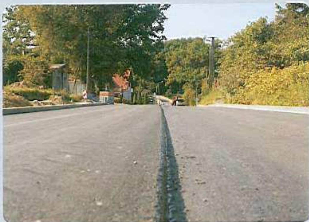
Prace na DW nr 239 wykonywane były pod ruchem w tak zwanym systemie połówkowym.
